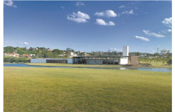
Centro de Apoio do Parque Ecológico (fonte: Arcoweb)
