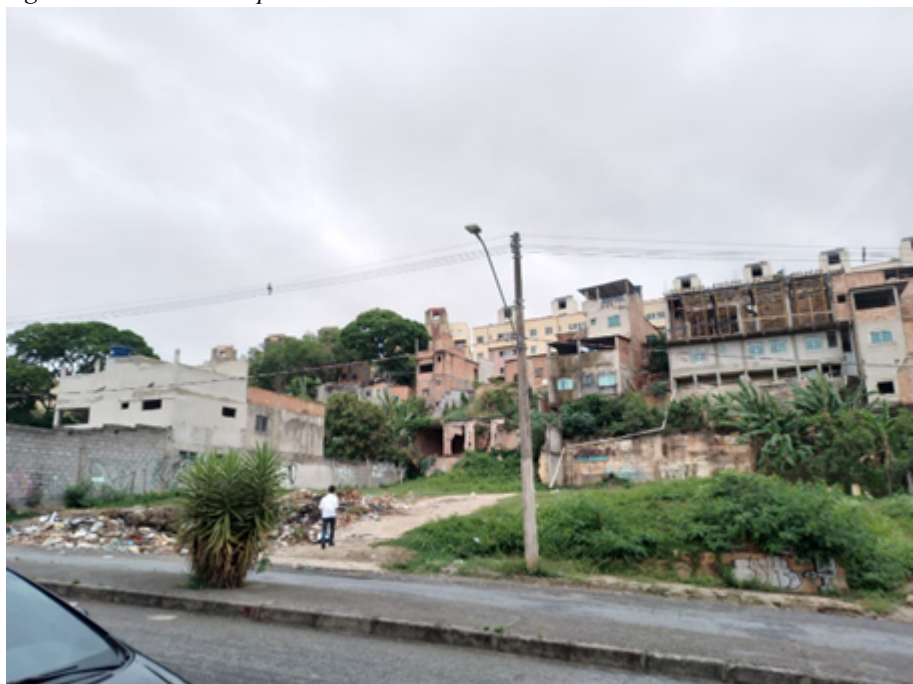
Figura 6 – Vista Rua Tupã
