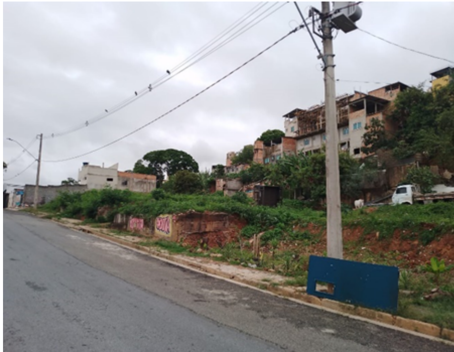
Figura 5 – Vista Rua Tupã
