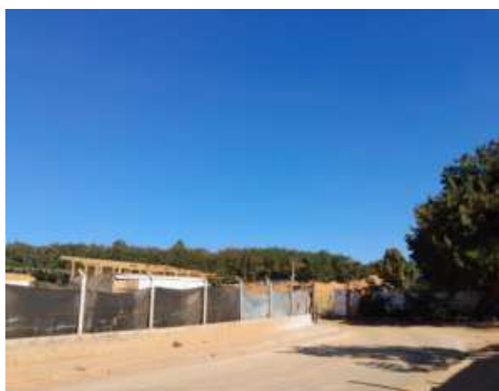
Figura 6 - Vista Rua da Balança
