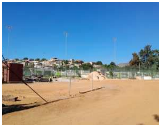
Figura 4 - Vista Rua da Balança
