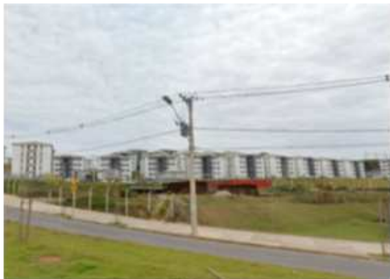
Figura 6 – Vista Rua Padre Argemiro Moreira
