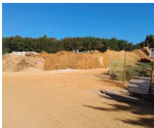
Figura 7 - Vista Rua da Balança
