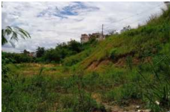
Figura 4 - Vista Avenida João XXIII
