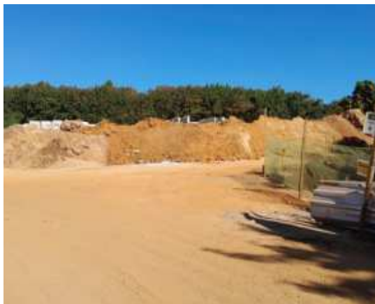
Figura 5 - Vista Rua da Balança
